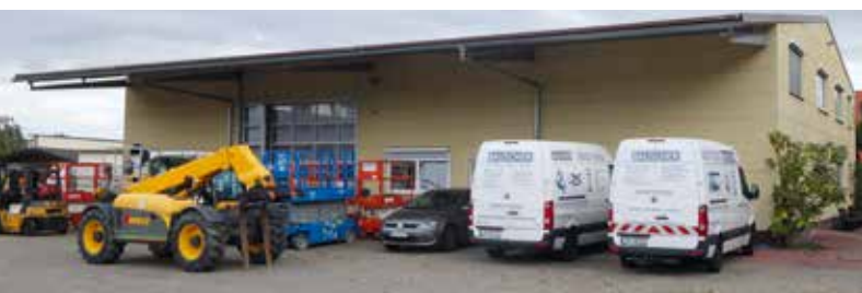
Der Hallenkomplex für Hubarbeitsbühnen. Neben Werkstatt befindet sich hier auch das Servicecenter mit Schulungsraum.
