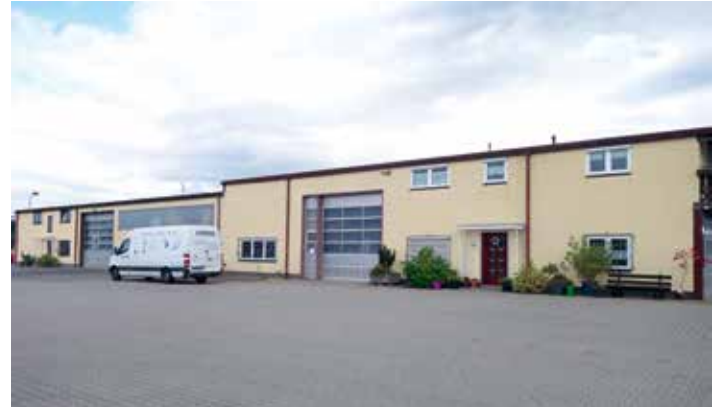
Die ältesten Hallen: im vorderen Bereich befinden sich die Büroräume mit Anmeldung und kleinem Verkaufsraum, dann folgen die ersten Werkstatthallen mit Rolltoren und abschließend das Wohnhaus des Firmengründers Günter Bauscher.
