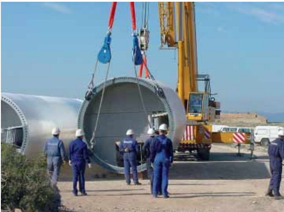
Turmsegment liegend mit vier Stück WKA 13500.
