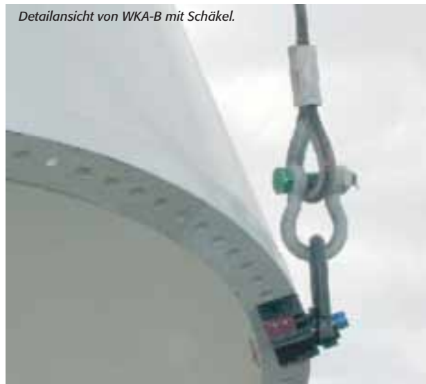
Detailansicht von WKA-B mit Schäkel.
