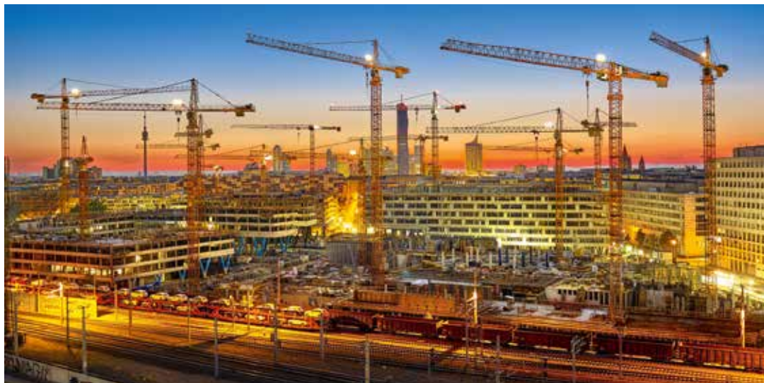
Liebherr-Turmdrehkran-Flotte am Austria Campus in Wien.
