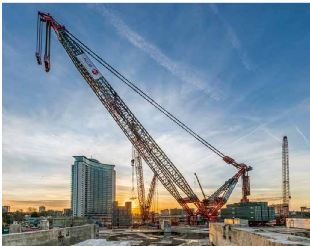
Beindruckend: der AL.SK 190 von ALE im Einsatz in London.
