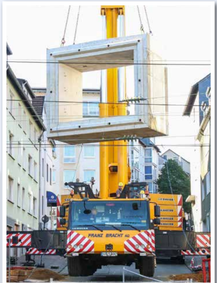
Der LTM 1400-7.1 von Bracht übernimmt auf der Baustelle das Einheben der Elemente. Bild: Michael Bergmann
