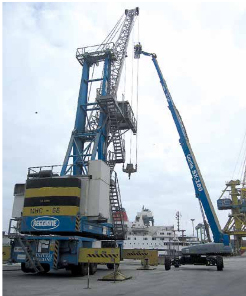
... bei Wartungsarbeiten an Kranen im Hafen von Casablanca in Marokko.
