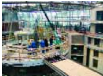
Mit nur 2,2 m Standbreite kommt der MC 104 auf der gläsernen Umwehrung des Aquariums in 25 m Höhe aus. (Aquariumssäule DomAquareé in Berlin)
