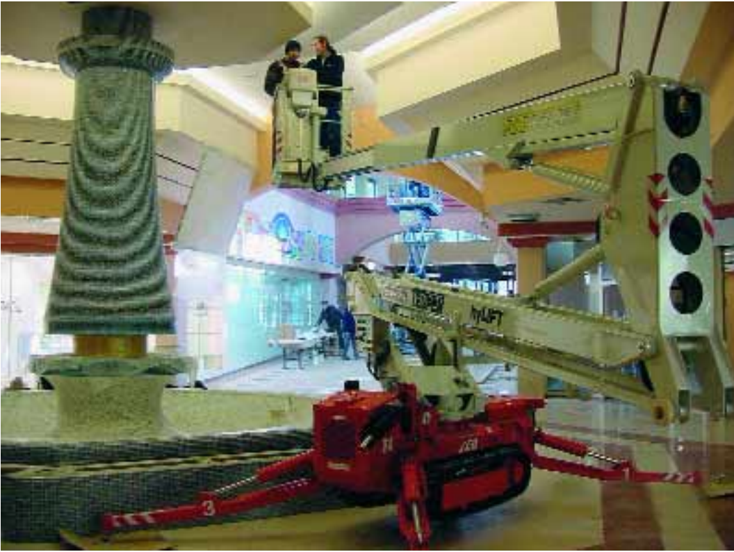
Auch empfindliche Bodenbeläge im Innenbereich stellen für Arbeitsbühnen auf Gummikettenfahrgestell kein Problem dar.
