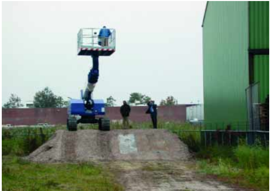
Große raupengetriebene Teleskop-Arbeitsbühnen ...
