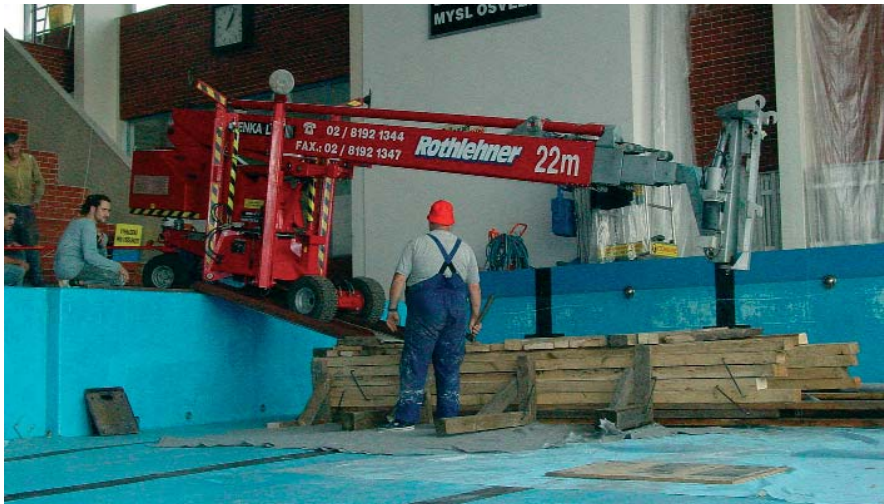
Aufgrund des Allrad-Rangierantriebs konnte die Hubarbeitsbühne problemlos auf den Beckenboden manövriert werden.
