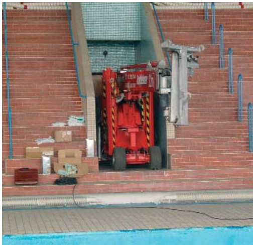
Die Anhänger-Arbeitsbühne Denka-Lift DL22N musste gleich zu Beginn des Einsatzes im Prager Schwimmbad eine Hürde meistern: die 0,95 m breite Eingangstür.
