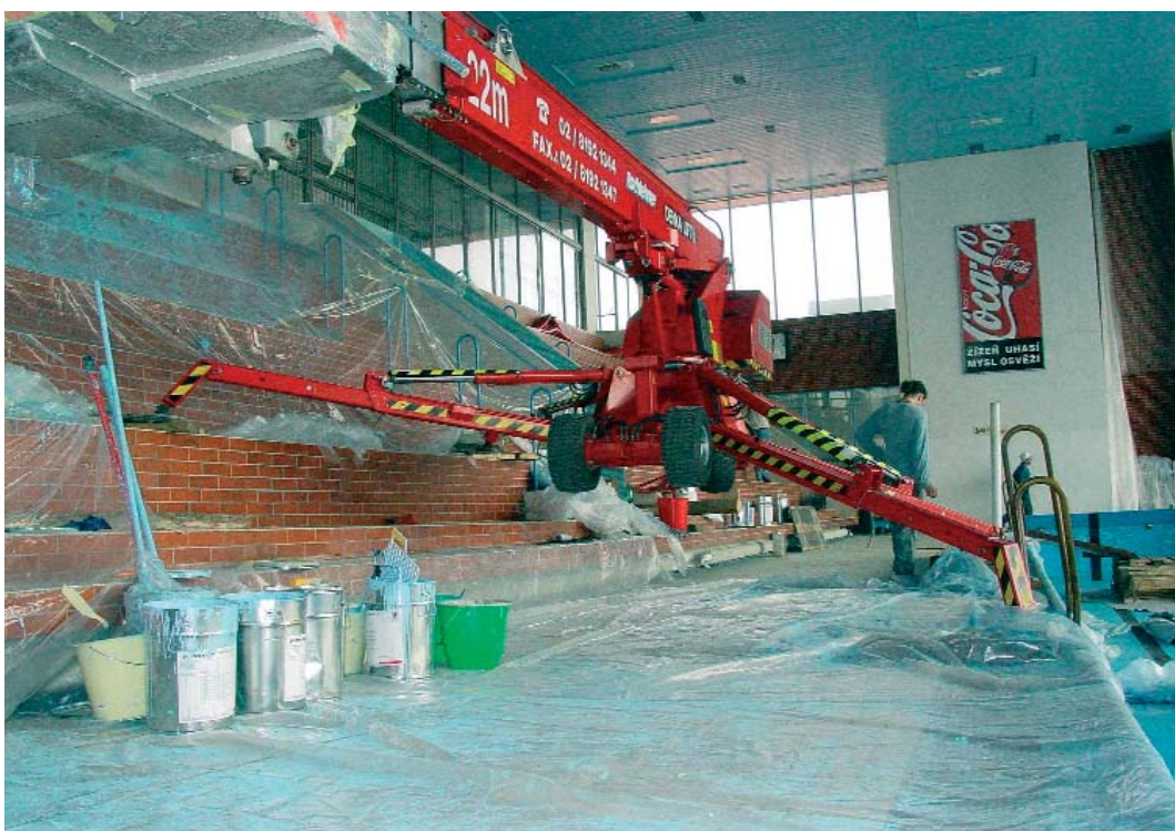
Dank variabler Abstützung des Denka-Lift Narrow konnte eine passende Aufstellposition gefunden werden.
