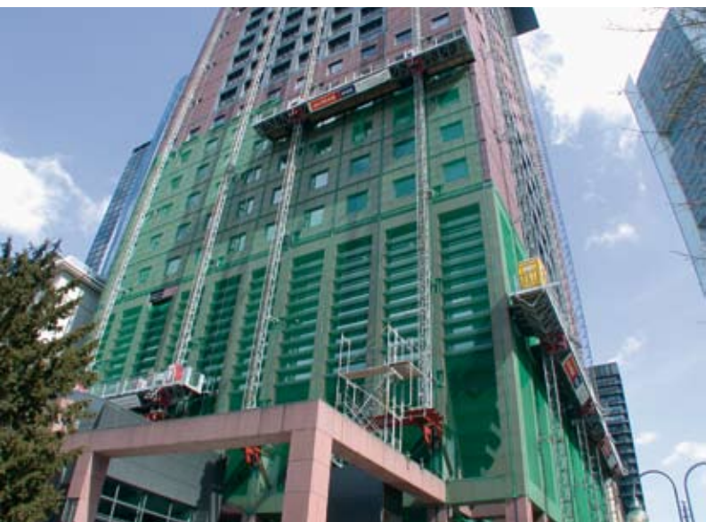
In unmittelbarer Nachbarschaft befinden sich auch mehrere Mastkletterbühnen von Alimak Hek im Einsatz. BM-Bild
