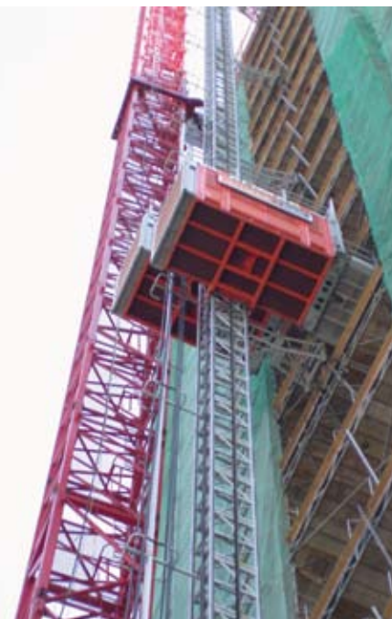
Ist der Aufzug an der gewählten Etage angekommen, klappt eine Rampe aus, die das Be- und Entladen, beispielsweise mit einer Schubkarre oder einem Hubwagen, erleichtert.
