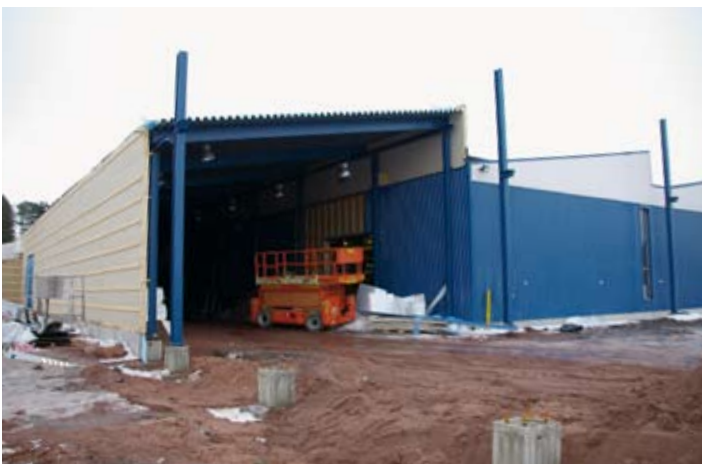
Der schon überdachte 1.600 m 2 große erste Bauabschnitt (links) der Produktionserweiterung, der im April in Betrieb genommen wurde. Einige Stahlpfeiler der zweiten Halle, die sich nach rechts erstrecken wird und im Juli 2007 in Betrieb genommen werden soll, sind ebenfalls zu sehen.
