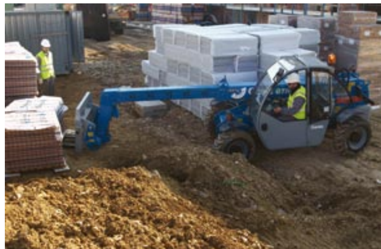
... an dem Teleskopstapler GTH-2506 vorgenommen.
