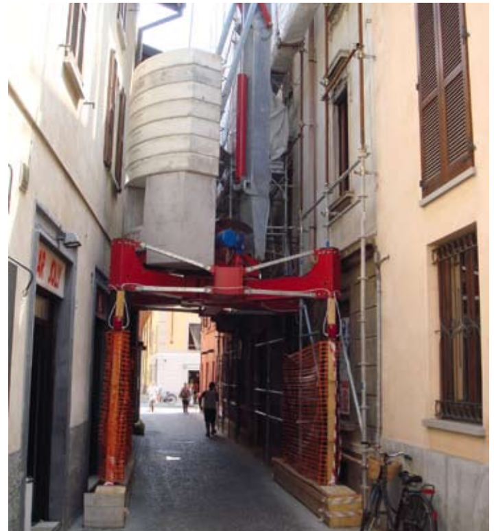
Gelco Clever Crane G 2424 TTBE beim Einsatz in der Altstadt des italienischen Bergamo: kleiner Schwenkradius und freie Verkehrsflächen.
