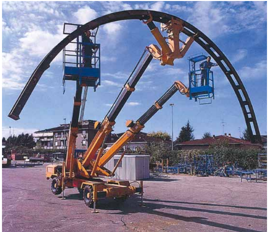
Bogen setzen leicht gemacht: Positionieren und Montage mit nur einer Maschine. Die Dieci 3 B.18 und 3 B.28.
