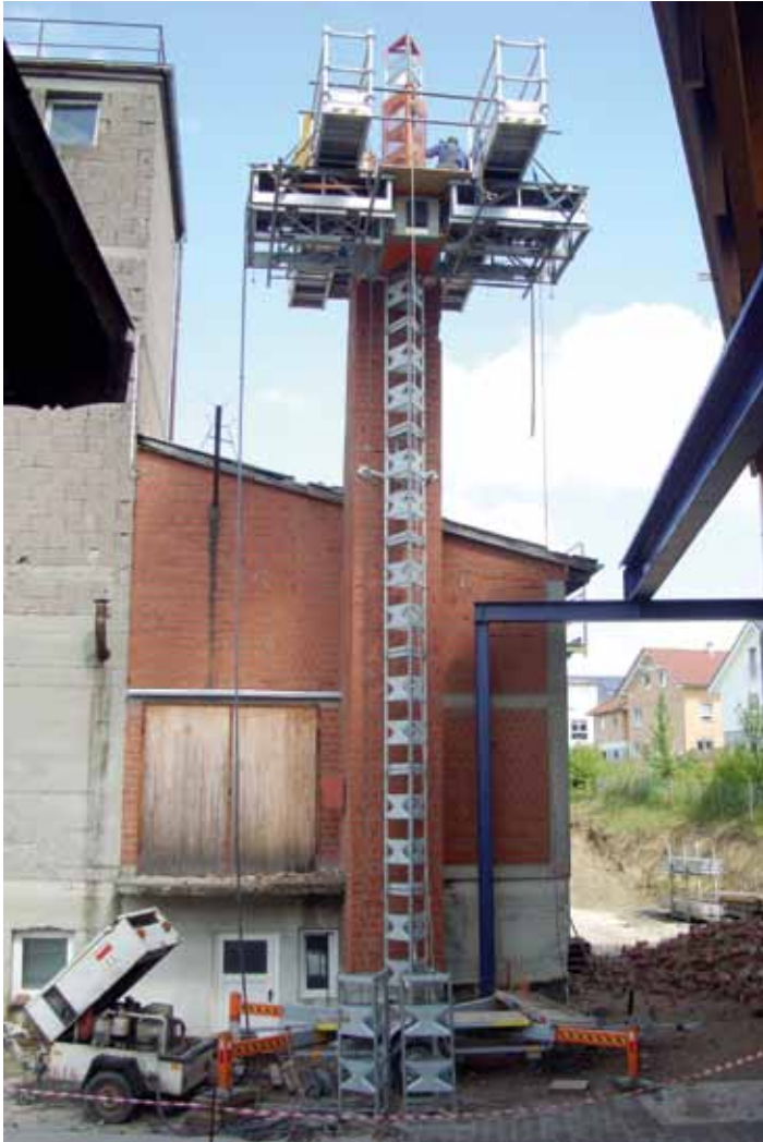
Die Mastkletterbühne FRSM 1500 auf Einachs-Pkw-Anhänger wurde am Kamin positioniert.
