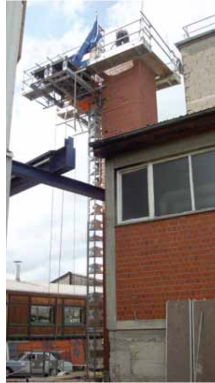
Die umlaufende Plattform beim Aufbau oberhalb einer angrenzenden Dachfläche. Die Aluminiumbrücken wurden anschließend fest mit Grundplattform verschraubt.
