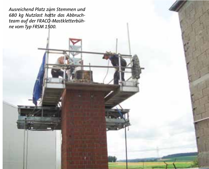
Die Mastkletterbühne FRSM 1500 auf Einachs-Pkw-Anhänger wurde am Kamin positioniert.
