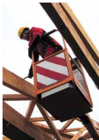
Der Mecaplus Einmannkorb bietet noch genügend Spielraum zwischen den Bindern.
