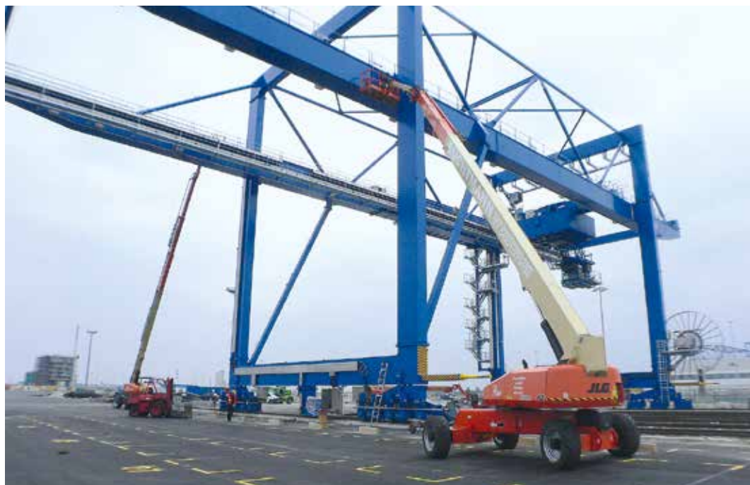
Zwei JLG Ultraboom Teleskopbühnen 1500SJ und eine 1350SJP im Einsatz ...
