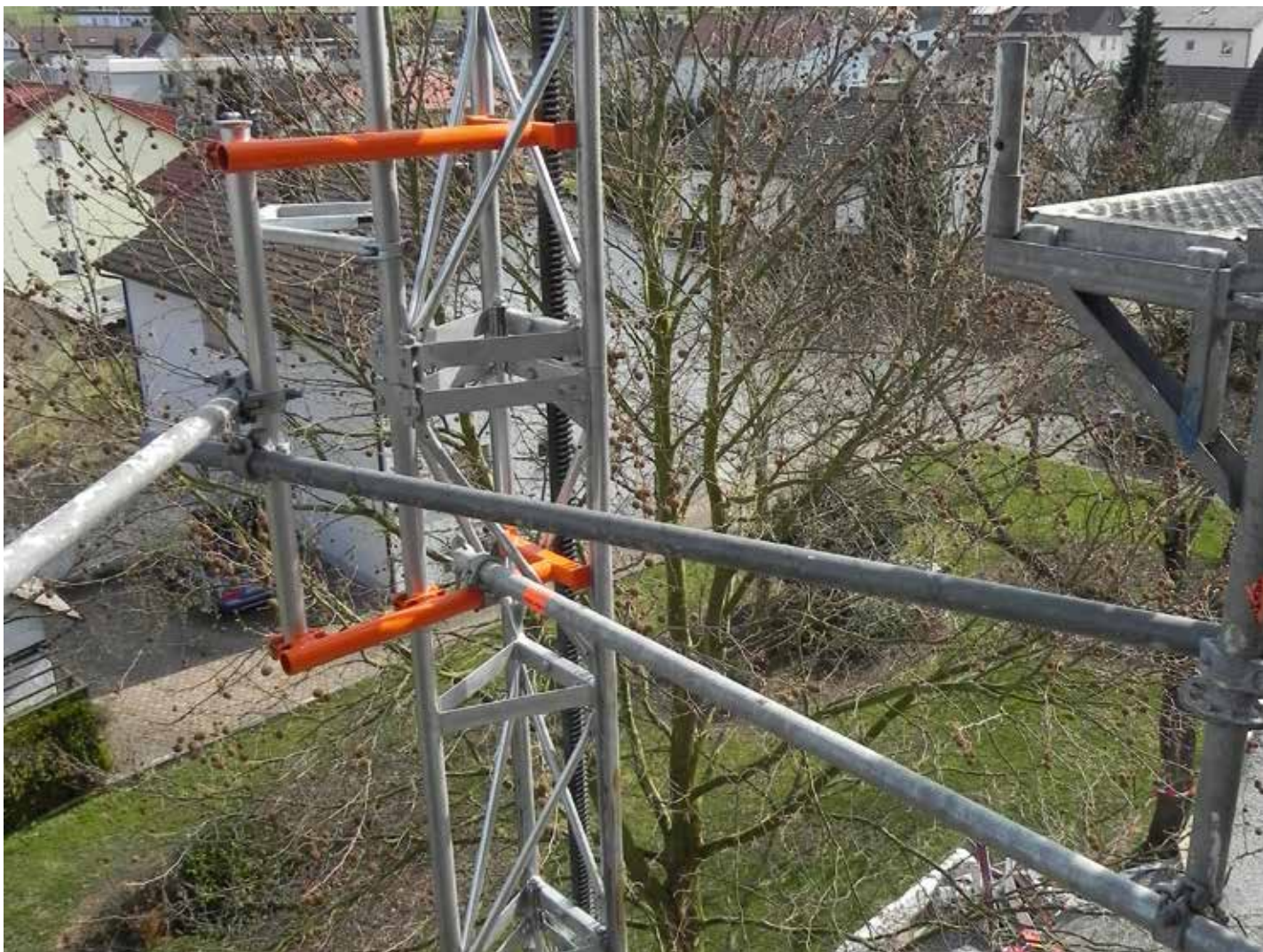
Neu entwickelter Verankerungsrahmen zum stufenlosen Anschluss.
