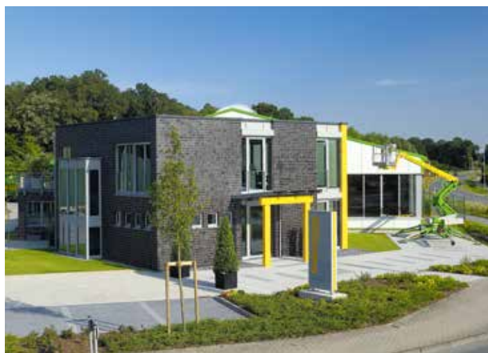
Im Vordergrund das neue Bürogebäude der Roggenland Arbeitsbühnen- und Staplervermietung.
