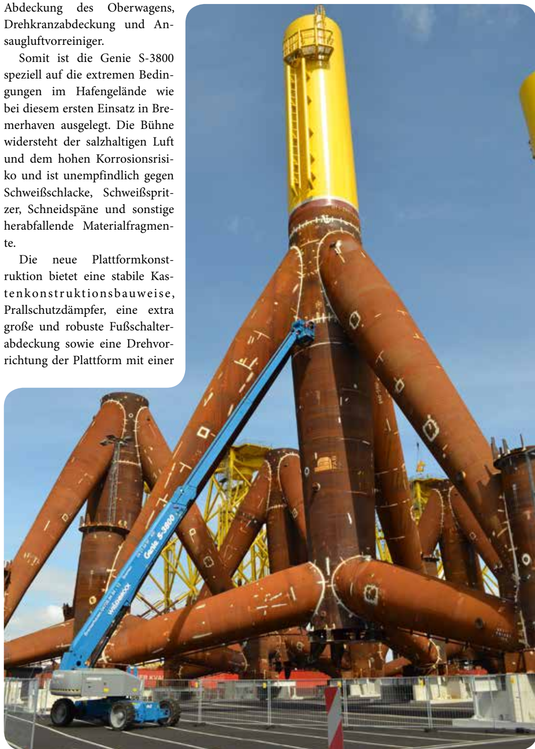
Die Genie S-3800 von Willenbrock Arbeitsbühnen bei Arbeiten an Tripoden – den ...
