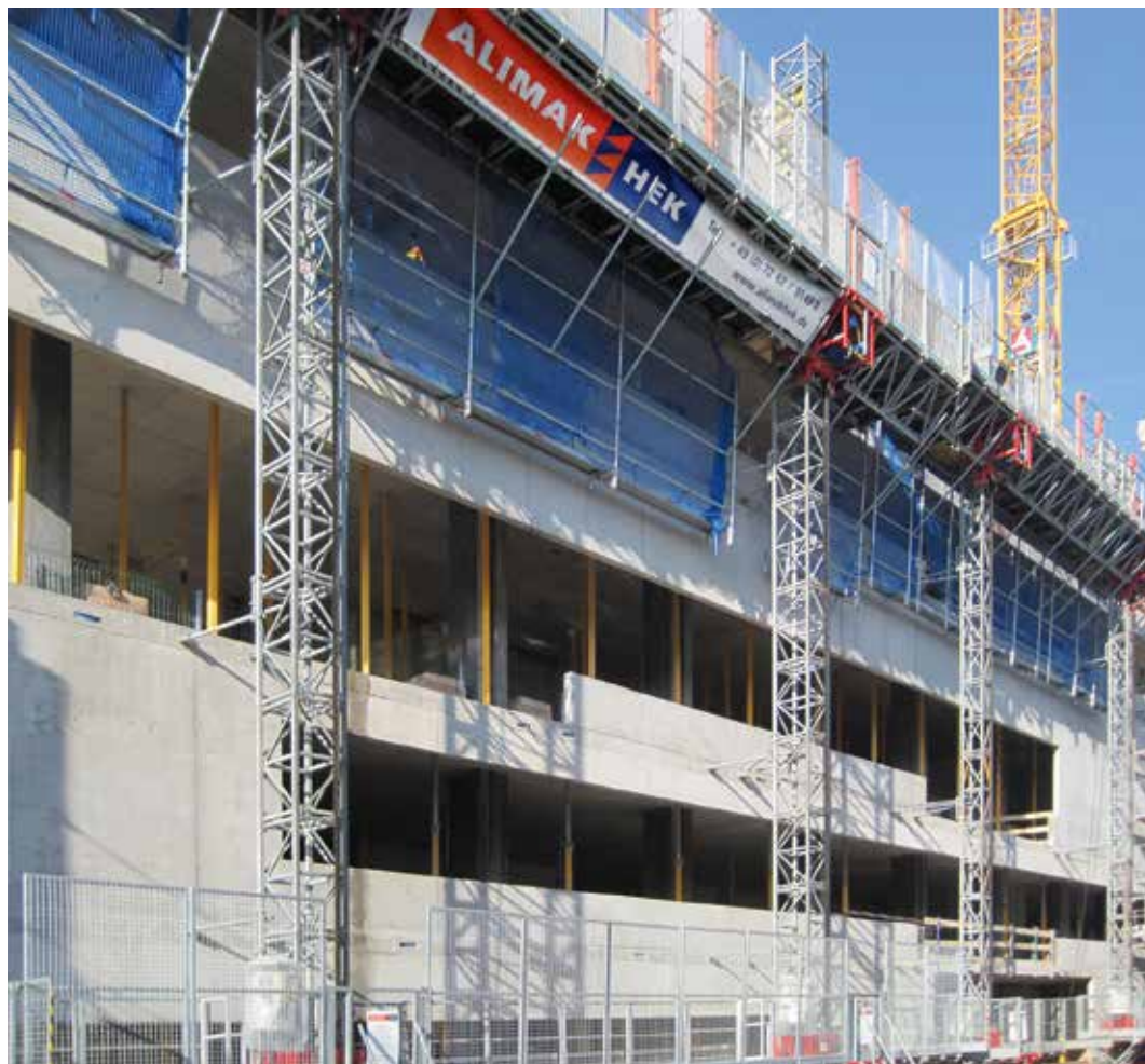
Schalung umschließende Nachlaufbühne mit Fangnetzen.
