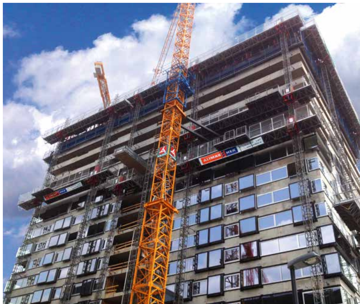
Rechte Bildhälfte: HEK MSHF mit rückwärtigen Verbreiterungen und erhöhten Rückengeländern zwischen Kranverankerungen.
