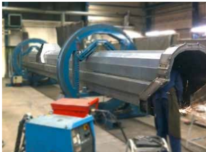
Um Schweißnähte und -verzug zu verringern, wird das sogenannte Zugwagen eingesetzt.
