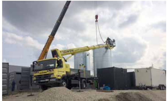
Ein Autokran hob die schweren Heizungstanks ein, die ...
