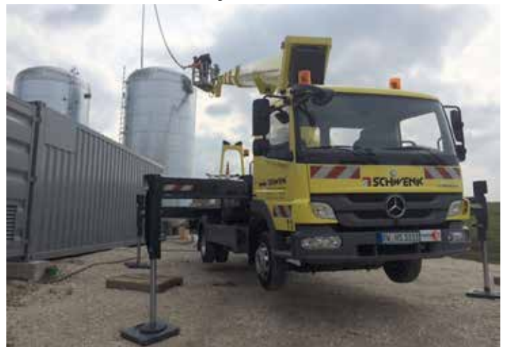
... von der Lkw-Arbeitsbühnen installiert wurden.
