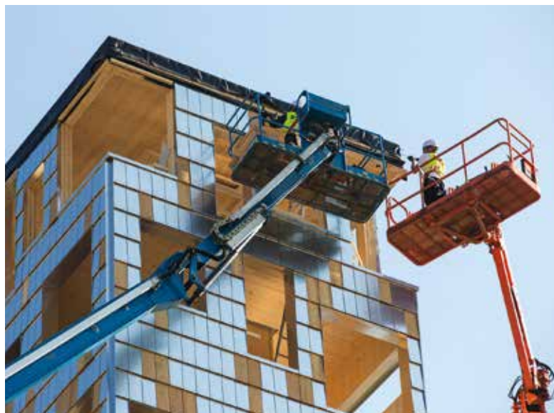
Mithilfe von Gelenkteleskopbühnen von System Lift wurde der Aussichtsturm „Himmelsstürmer“ ...
