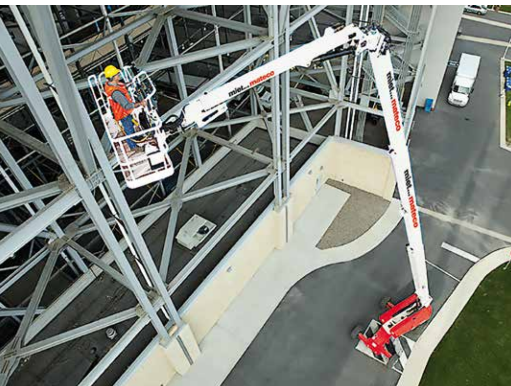
Die neue T 477 von mateco im Einsatz
