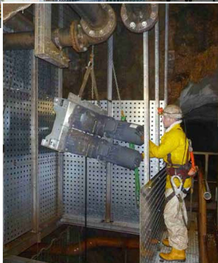
Einbringen des Fahrkorb-Antriebs.
