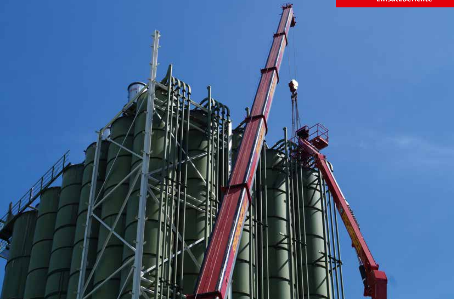
Eine heikle Präzisionsübung in Zusammenarbeit mit einem 220-Tonnen Kran.
