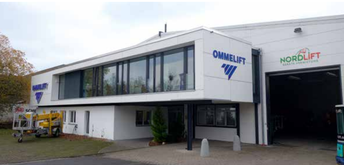
An der neu erbauten zweiten Etage ist klar erkennbar, wer dort seinen Sitz hat: Ommelift.
