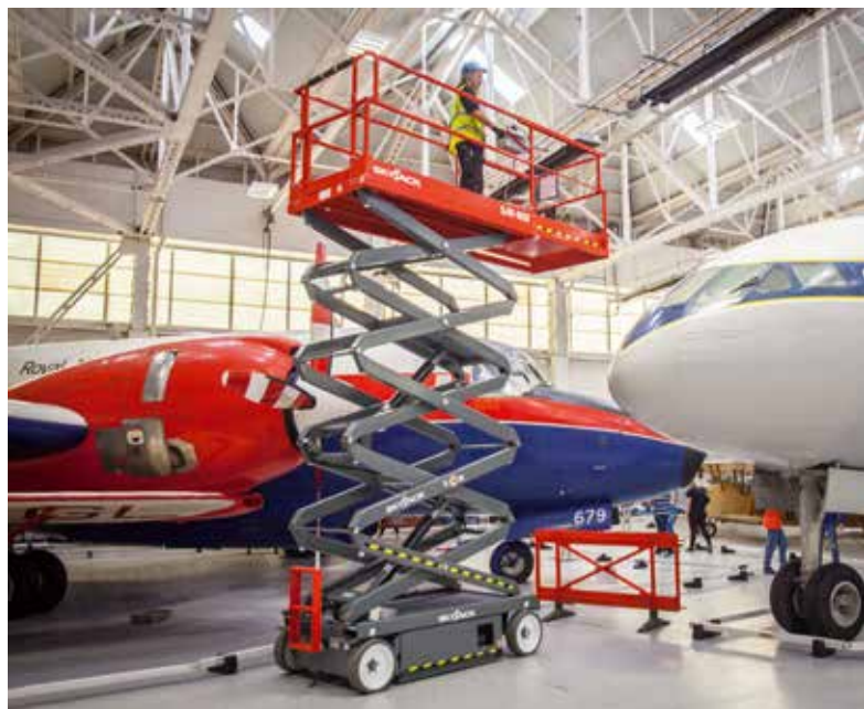
Die Elektroscherenbühne SJIII 4632 DC von Skyjack im Einsatz beim Einbau einer Feuerlöschanlage im RAF Cosford, in der Nähe von Birmingham, Großbritannien.
