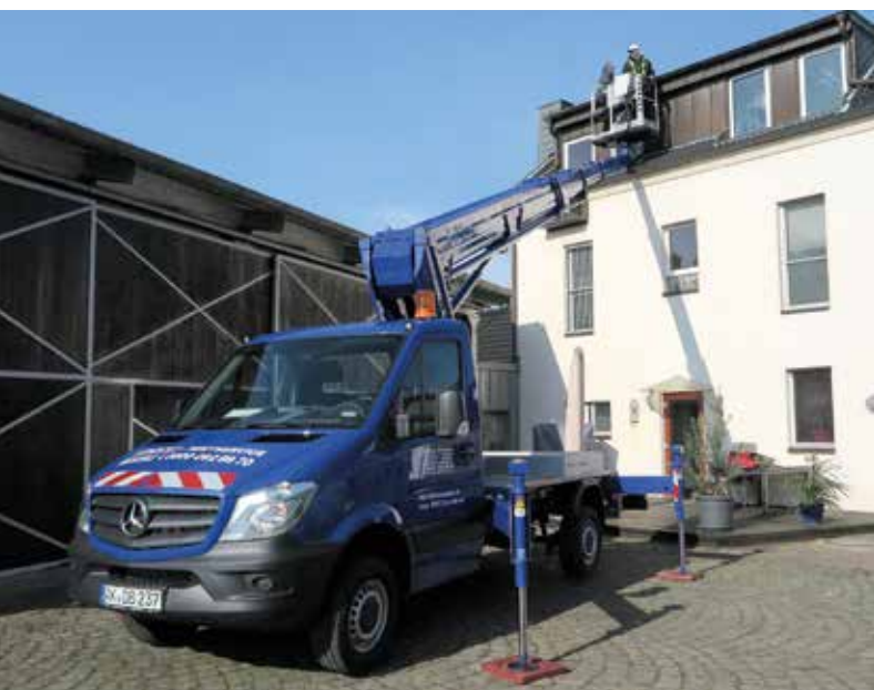
Überzeugend bei Dacharbeiten: Lkw-Bühne LB 270 T mit einer maximalen seitlichen Reichweite von 16,40 m und einer maximalen Arbeitshöhe von 27 m.
