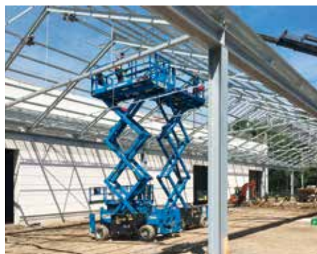
HKL punktete bei dem Projekt insbesondere mit Know-how und Spezialgeräten für die in luftiger Höhe anfallenden Stahl-, Aluminium- und Glasbauarbeiten.
