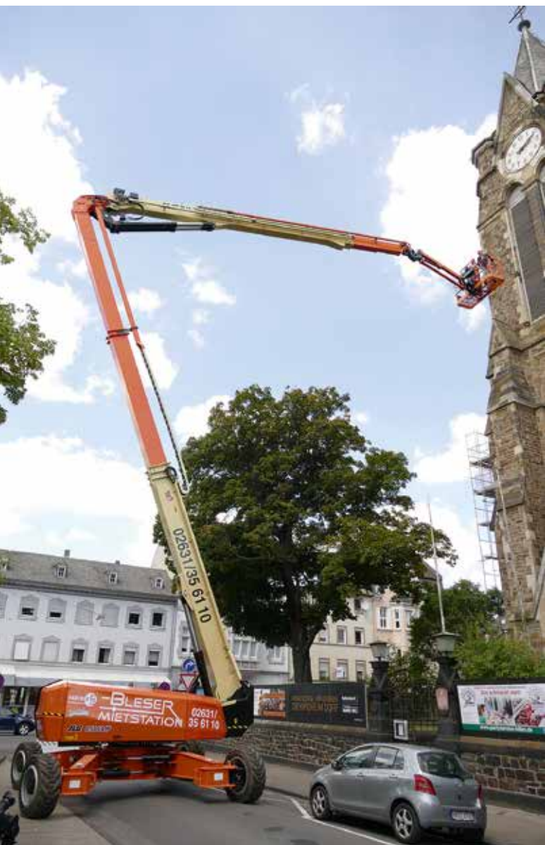
Mit 48,15m Arbeitshöhe und einer seitliche Arbeitsreichweite von 23,55 m ...
