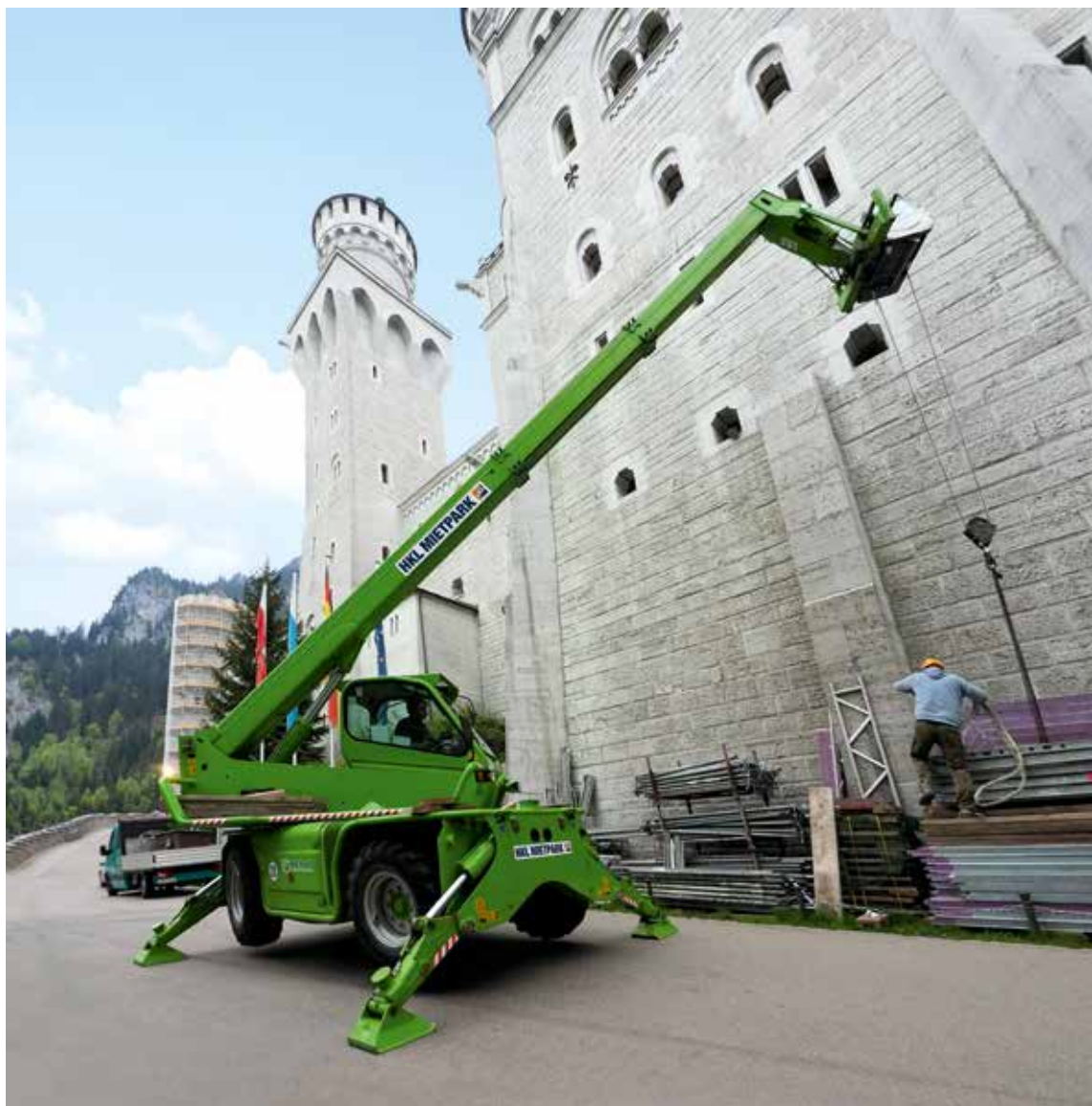
Der von HKL gemietete Merlo Roto Teleskopstapler wurde auf der „Neuschwansteinstraße“ direkt unterhalb des Schlosses positioniert. Hier hingte die BSB Bau- und Spezialgerüstbau GmbH das Gerüstmaterial an die Maschine an.
