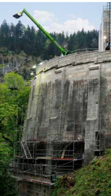
Mit einer Seilwinde ausgestattet, ließ die Maschine aus dem HKL MIETPARK das angehängte Gerüstmaterial von oben in die Tiefe der Pöllatschlucht herunter.
