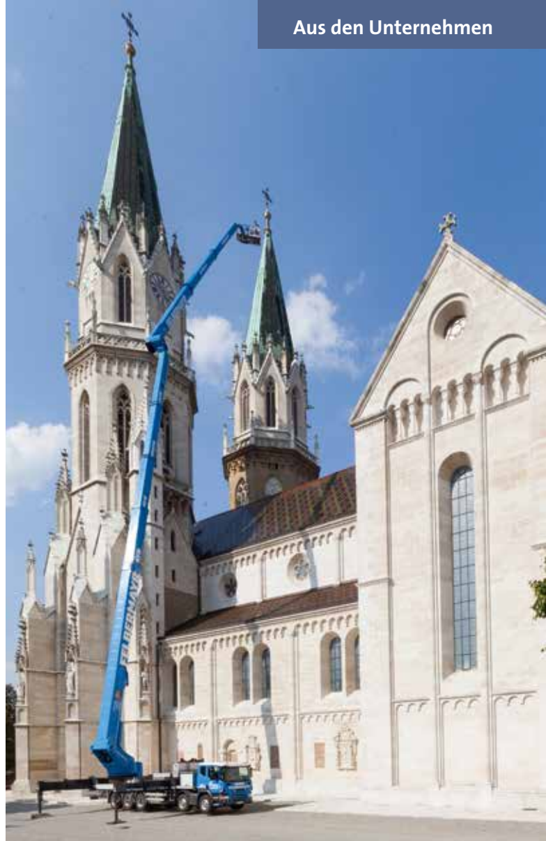
Von einem Aufstellpunkt aus konnten schließlich auch Arbeiten am hinteren Turm ...
