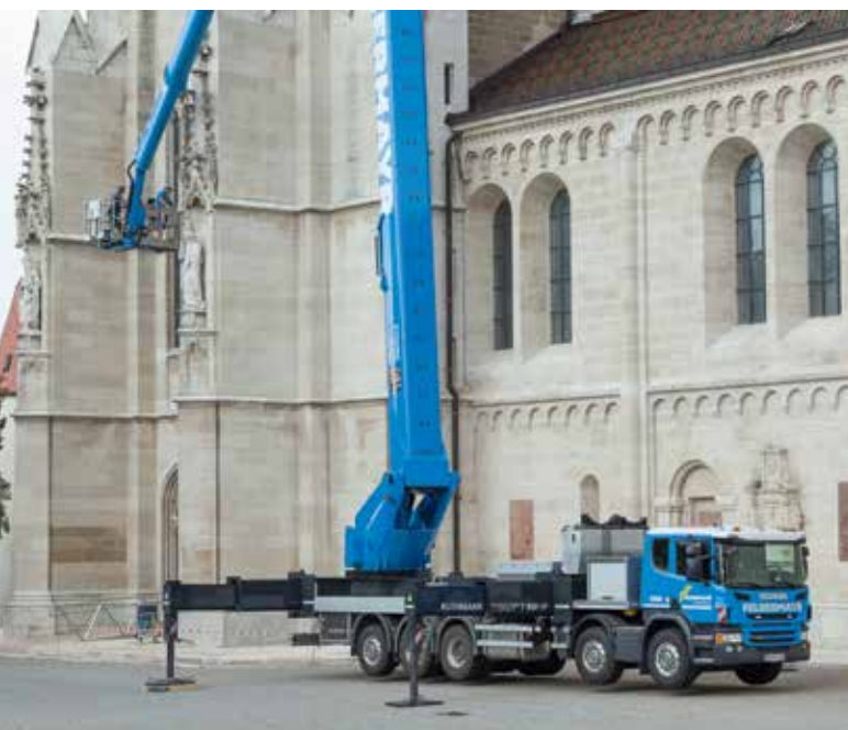
An dem Stift wurden mit dem 90 m-Ruthmann-Steiger Sanierungsarbeiten durchgeführt. Wie beispielsweise hier an einer der unteren Skulpturen.
