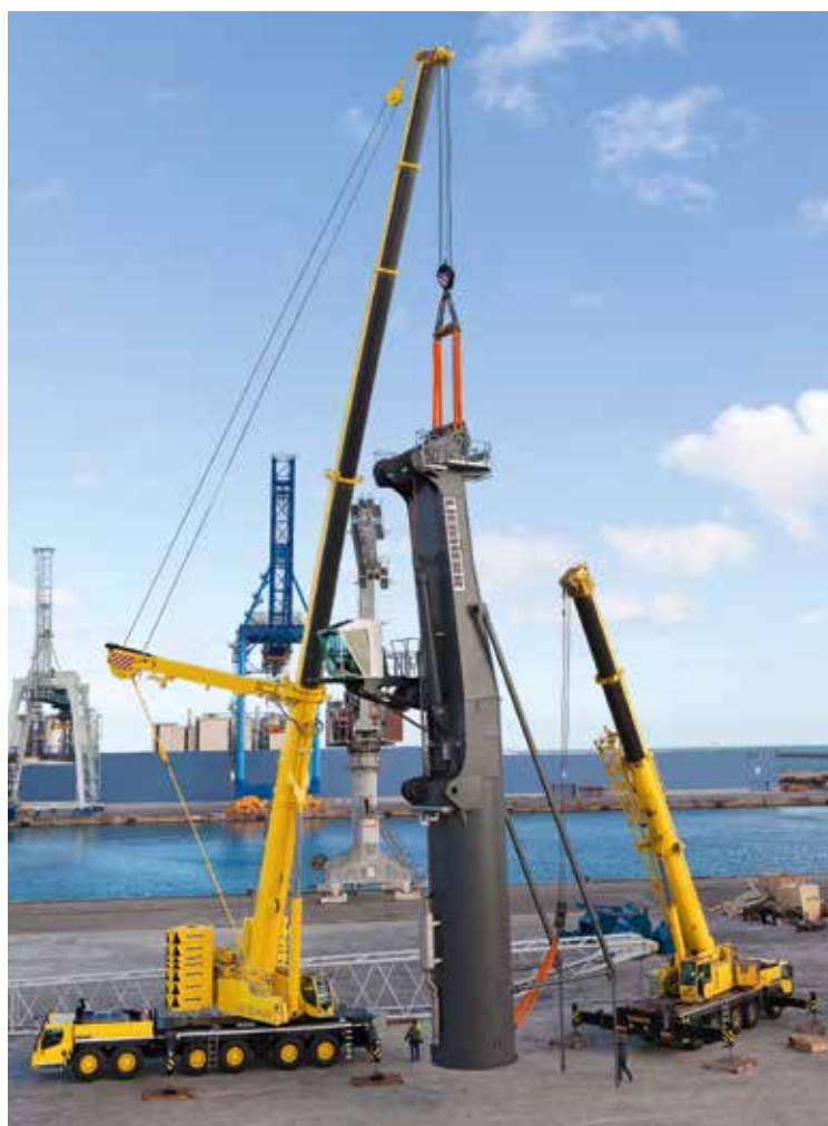
Liebherr-Mobilkrane montieren einen Hafemobilkran im Industriehafen von Sète, Frankreich
