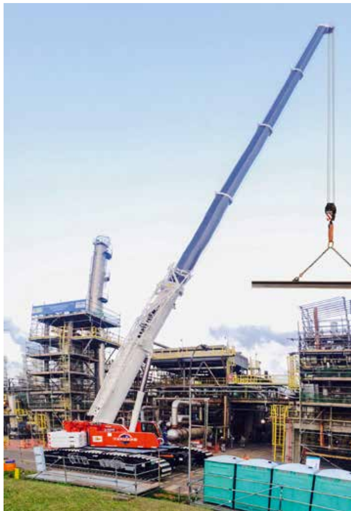
Der Liebherr Teleskop-Raupenkran LTR 1220 von Guindastes Tatuapé arbeitet in einer petrochemischen Anlage in Mauá im Bundesstaat São Paulo.
