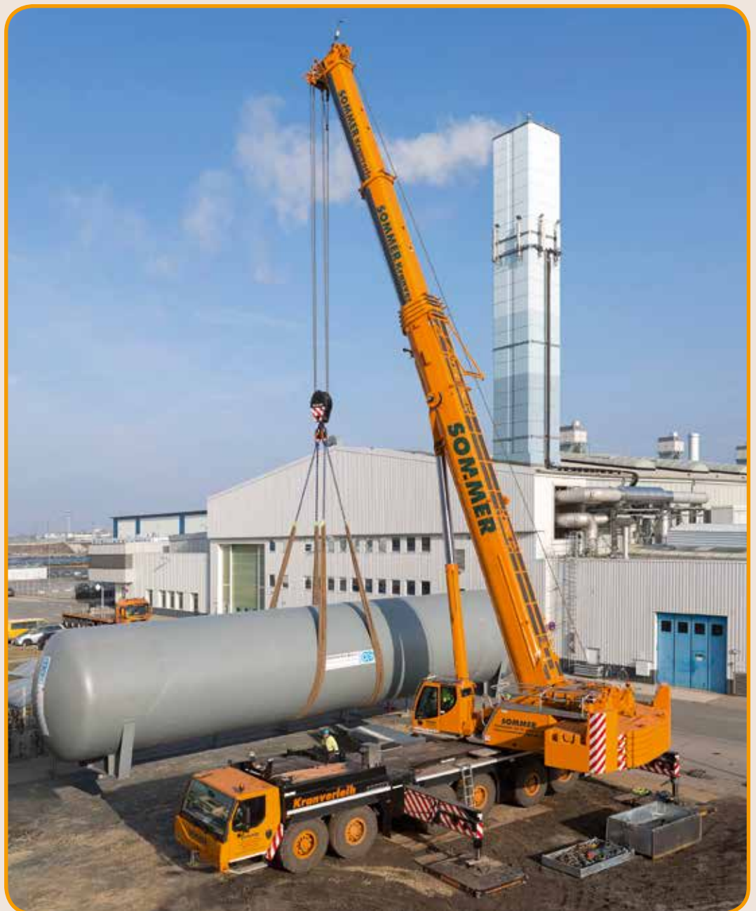
Der neue LTM 1300-6.2 positioniert den 50 t schweren Heißwasser-Speicher.
