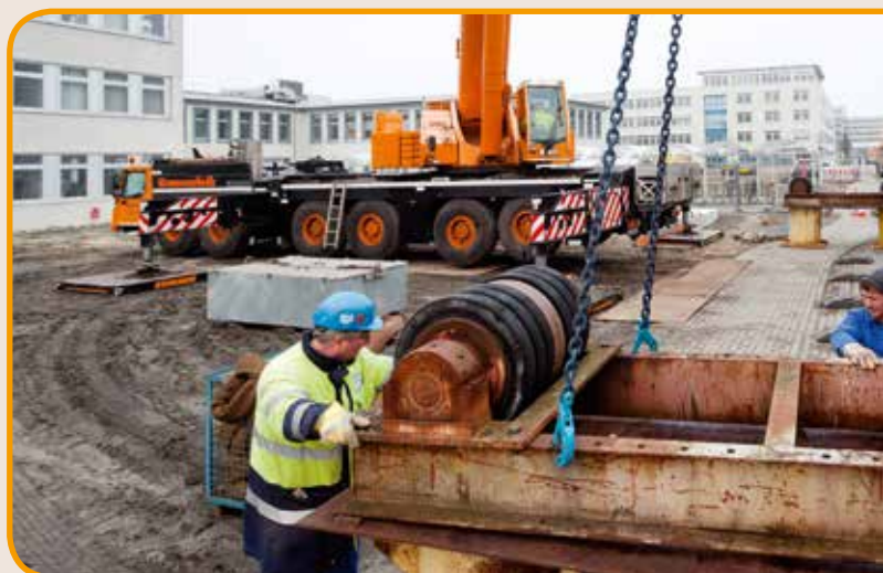
Auf großen Rollen wird der stählerne Kessel zwischengelagert und in Position gedreht.
