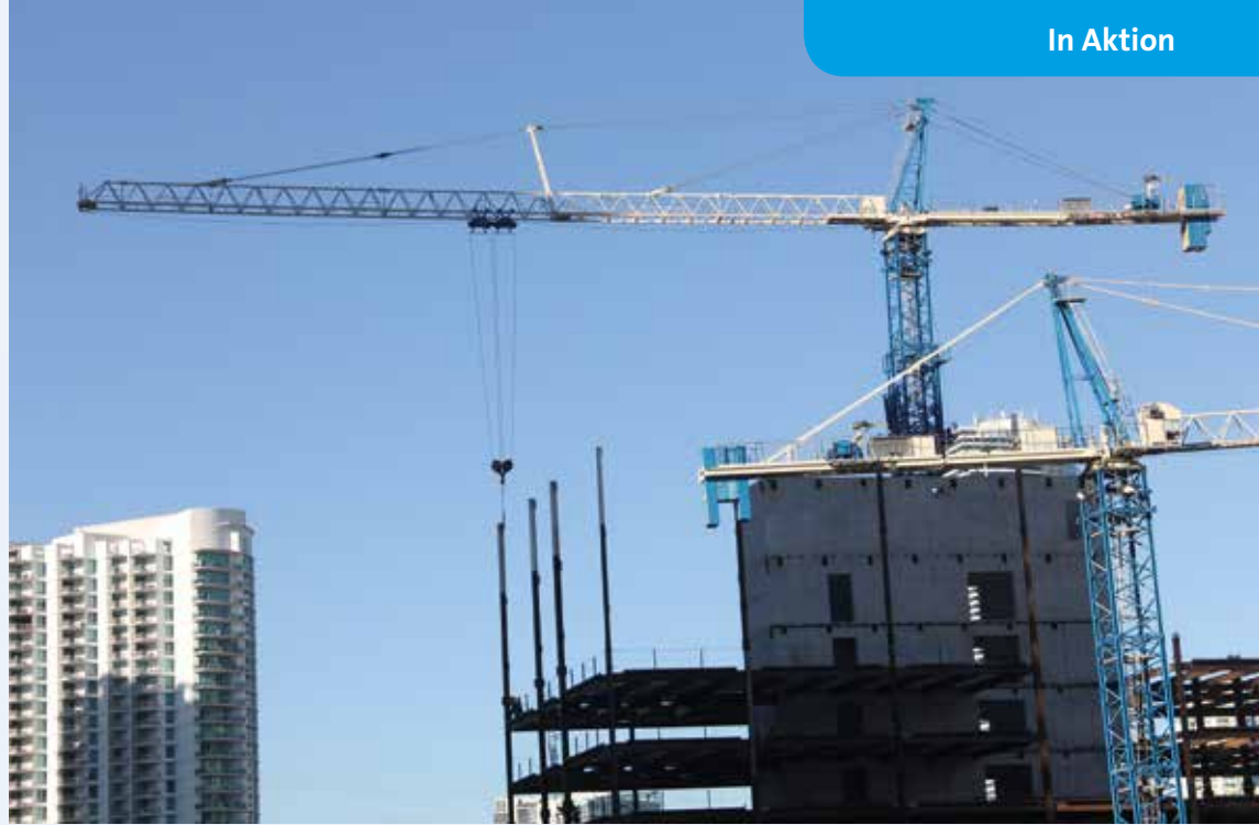
Bei dem Projekt in Miami kamen auch Hammerkopfkranen von Terex zum Einsatz.
