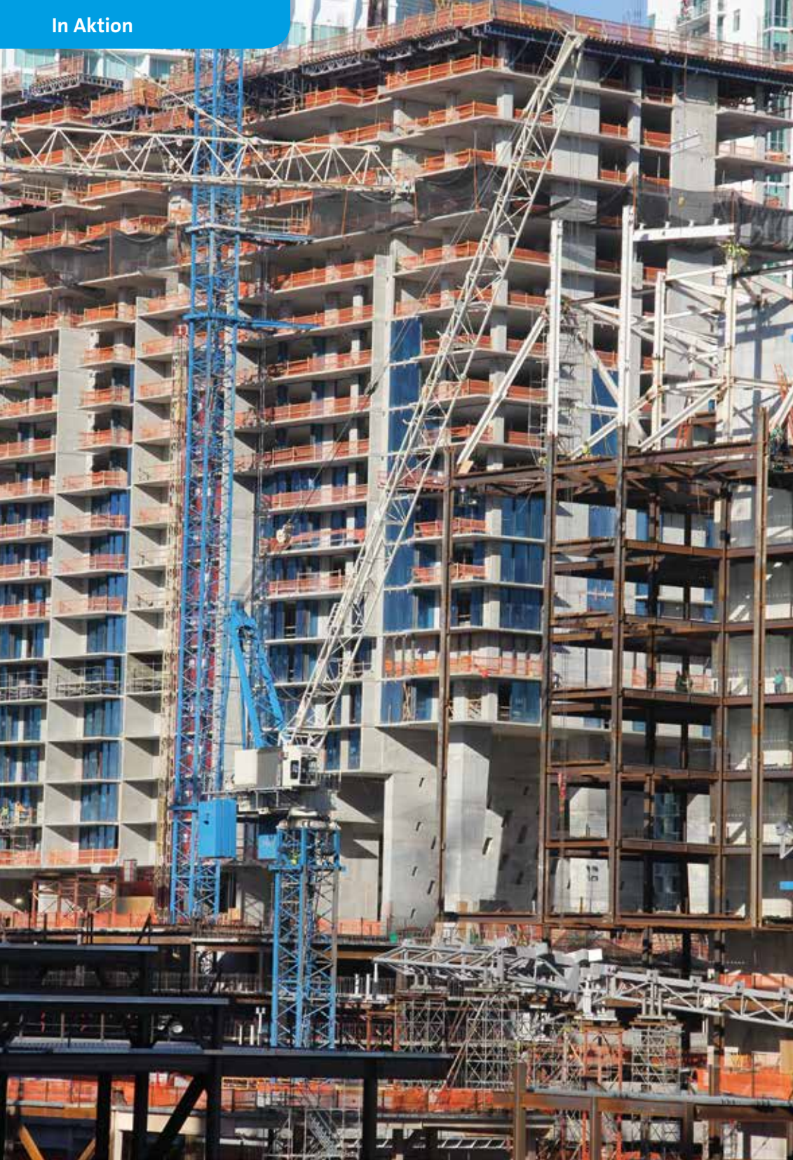
Elf Krane, darunter auch Wippkrane, waren auf der Baustelle im Einsatz.
