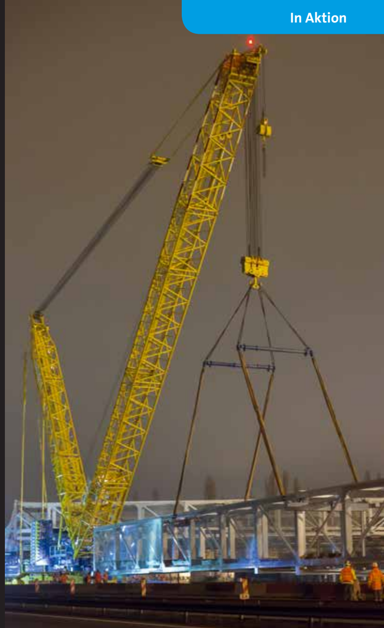
Für den Hub rüsteten die Sarens-Monteurs den Superlift 3800 in SSL1 Konfiguration mit 54 m Hauptausleger.
