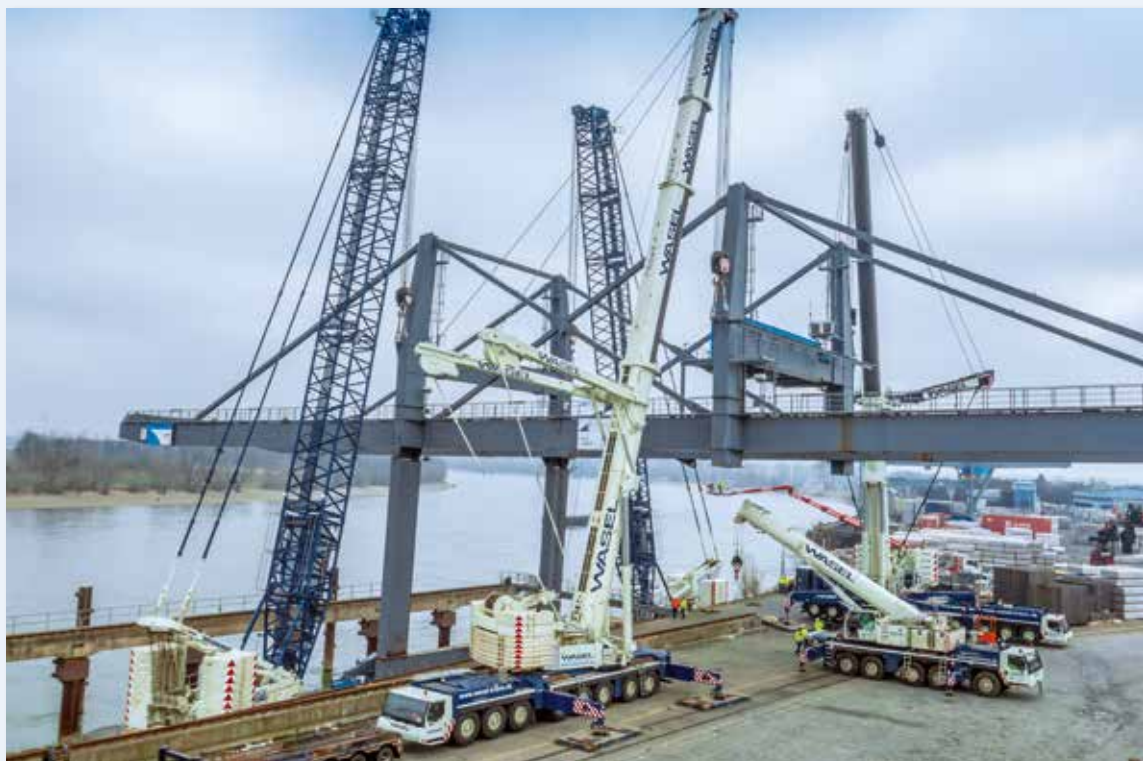
Die landseitigen Stützen fehlen noch: das Wasel-Aufgebot am Rhein bei Dormagen.
