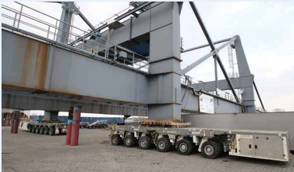
In Zusammenarbeit mit Multilift wurde die Brücke zunächst verfahren.
