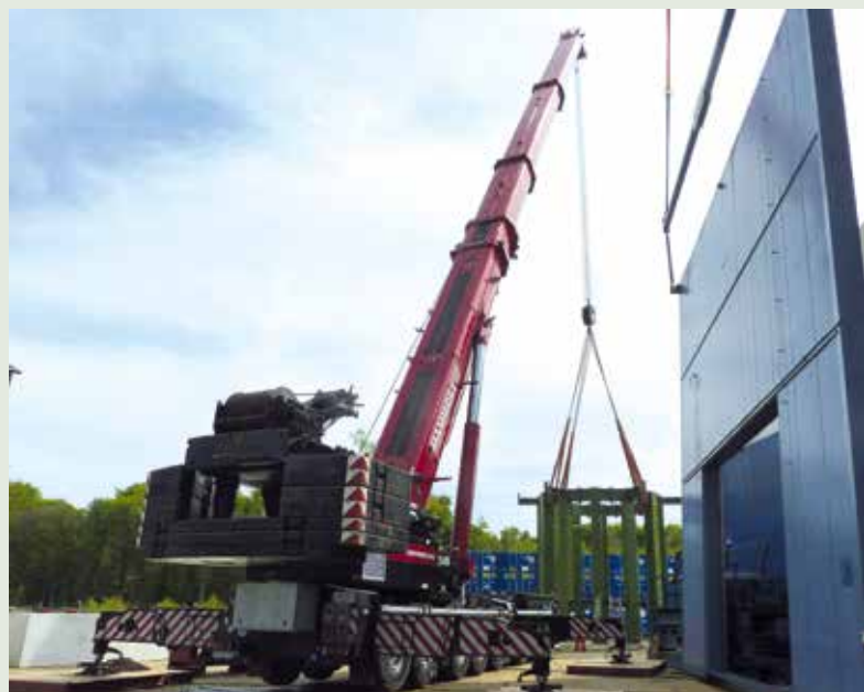
Es geht auf Feierabend zu. Das Traggestell wird abgesetzt, das Tor kann wieder eingehoben werden.
