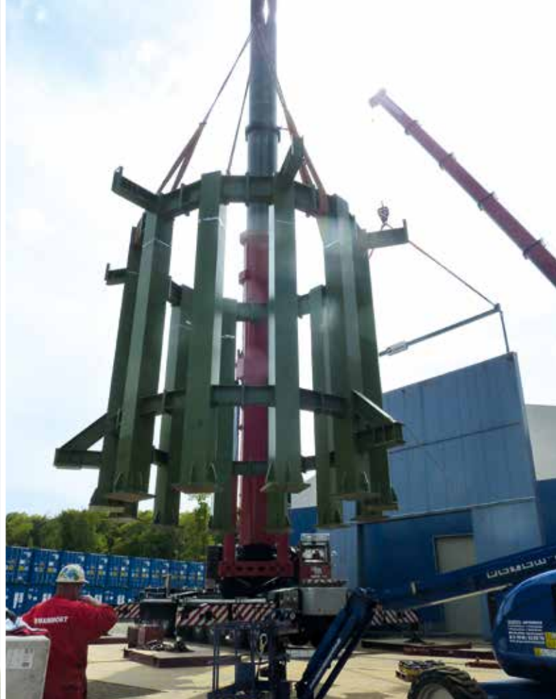
Auftritt für den LTM 1500: Das Traggestell des Reaktorbehälters wird umgesetzt.
