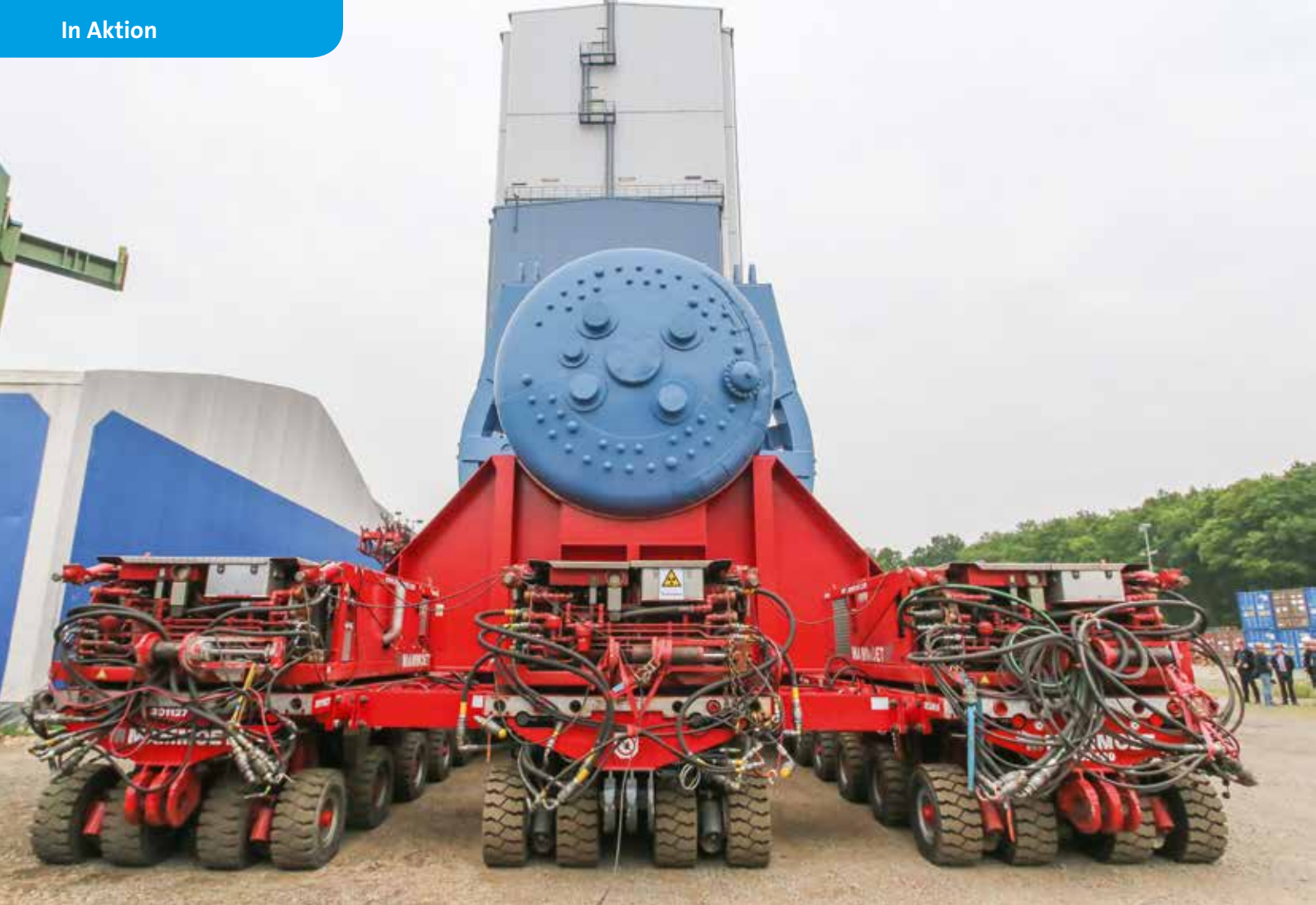
Bereit für die letzte Etappe: Der Reaktorbehälter ist auf SPMTs verladen und „parkt“ vor der Materialschleuse. Bild: Michael Bergmann
