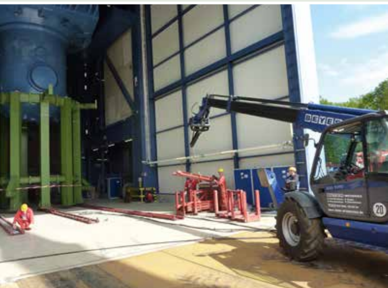
Die Verschubbahn wird vorbereitet.
