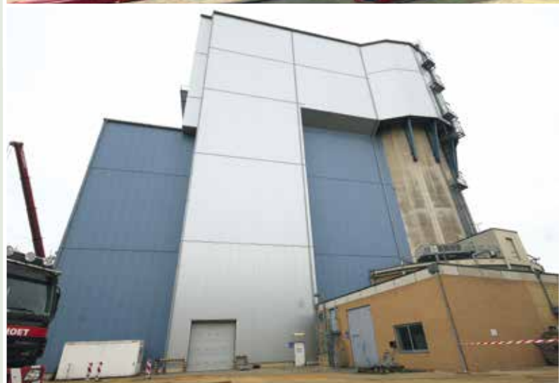
Der Aufwand des Rückbaus wird auch an den Gebäudedimensionen deutlich: Rechts außen das Reaktorgebäude, daneben der deutlich größere Anbau – die Materialschleuse. KM-Bild
