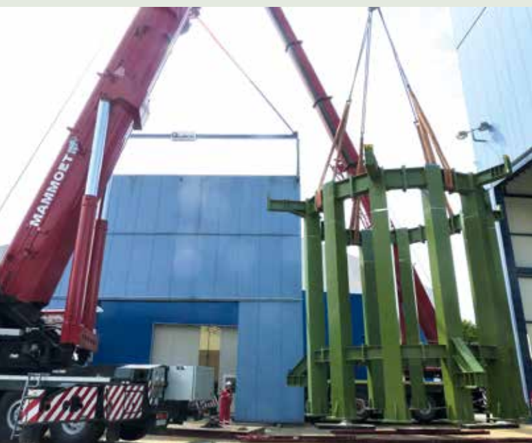
Los geht es: Das Traggestell ist angeschlagen, der Hub beginnt.
