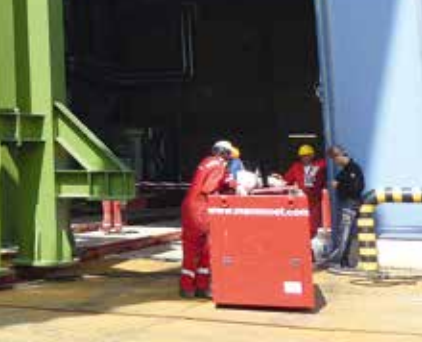
Auf Verschubbahnen wird das Traggestell aus der Materialschleuse heraus verschoben. KM-Bilder
