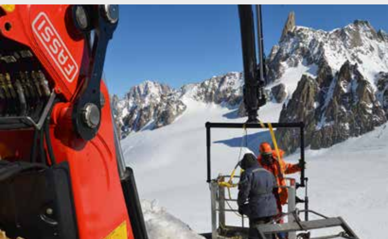
Vom Arbeitskorb aus konnten unter anderem Bolzen festgezogen und Türen eingebaut werden.
