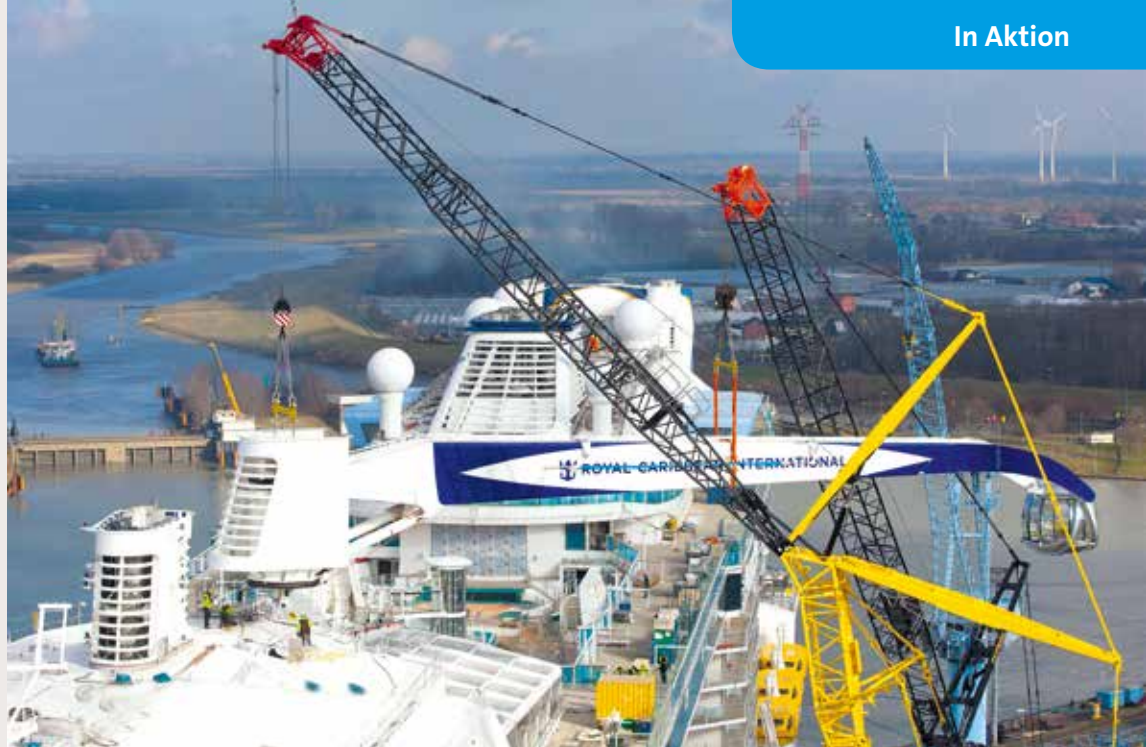
110 t Bruttolast an beiden Kranhaken: die Aussichts-gondel „North Star“ wird am nächsten Morgen auf dem obersten Deck des Schiffes montiert. Bild: Meyer Werft / M. Wessels
