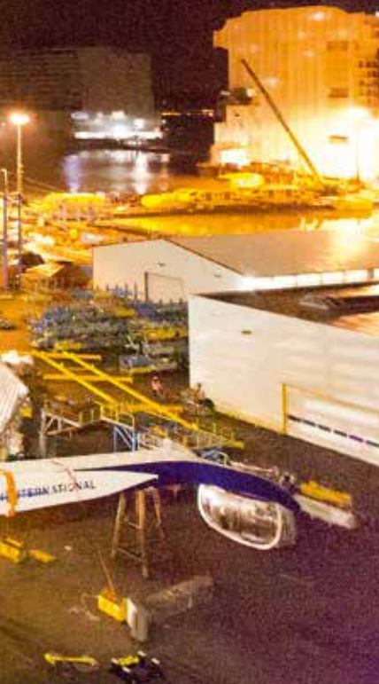
110 t Bruttolast an beiden Kranhaken: die Aussichts-gondel „North Star“ wird am nächsten Morgen auf dem obersten Deck des Schiffes montiert. Bild: Meyer Werft / M. Wessels
