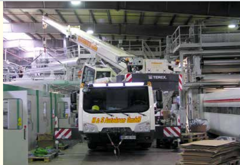
Halleneinsatz für einen Challenger 3160.
