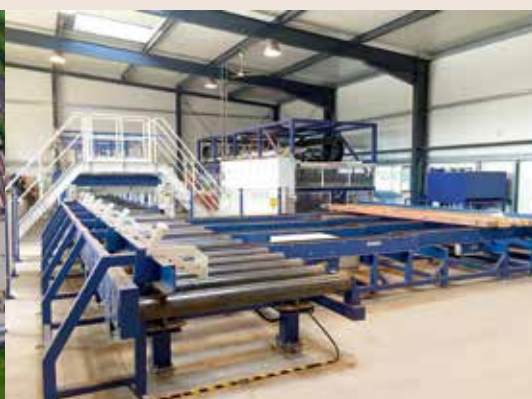
Für die Produktionsanlagen von Ko-Mats wurde im Jahr 2012 eine neue Halle in Bad Bentheim errichtet. Bild: Ko-Mats
