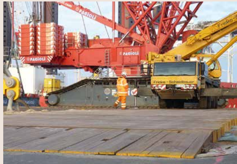
In Cuxhaven bereitgestellt – spezielle Bongossirampen und 8 m breite Matten um das Gesamtgewicht des Krans mit Last von circa 2.400 t tragen zu können. Bild: Ko-Mats
