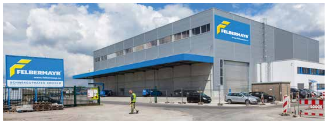
Die neue Felbermayr Deutschland-Zentrale im Rheinhafen Krefeld. Neben Krefeld betreibt Felbermayr den Schwerguthafen Linz in Österreich an der Donau, der für die Anlage in Krefeld Modell stand.
