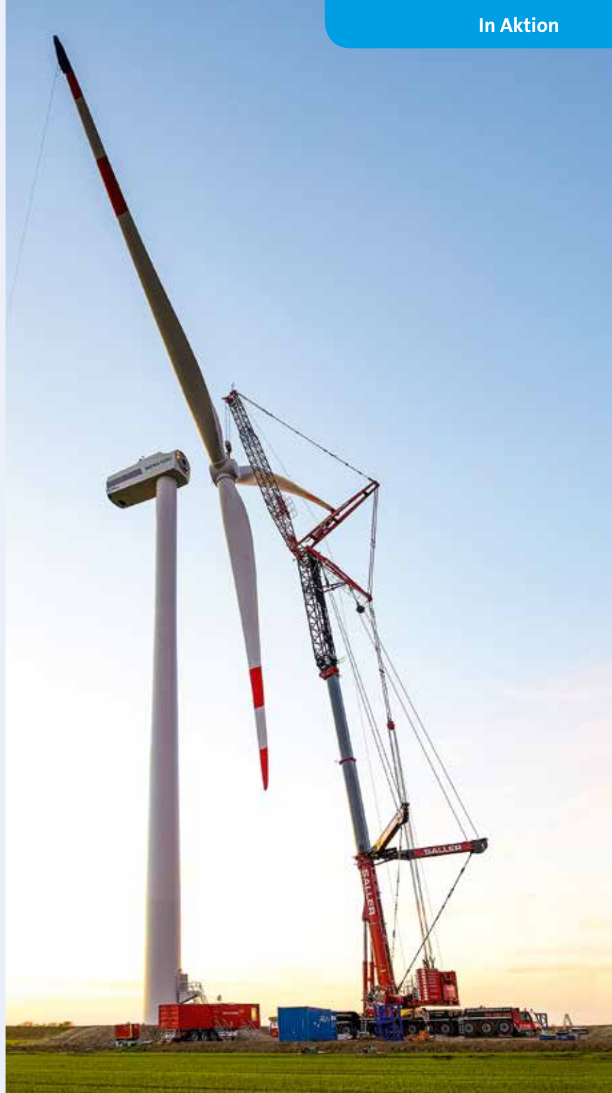
Der Liebherr-Mobilkran LTM 1750-9.1 montiert den Flügelstern auf 80 m Nabenhöhe.
