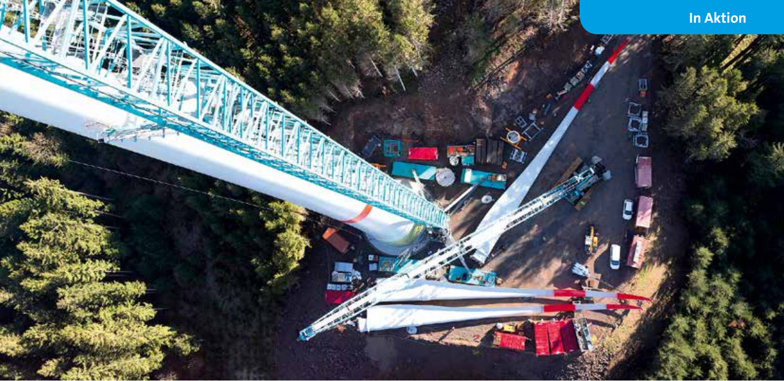
Ein großer Vorteil des Liebherr-Flat-Top-Krans liegt unter anderem in seinem sehr geringen Platzbedarf.
