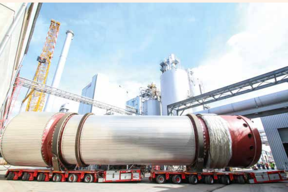
Auf Goldhofer-Selbstfahrrn wurden sowohl die alten als auch die neuen Trockner befördert.
