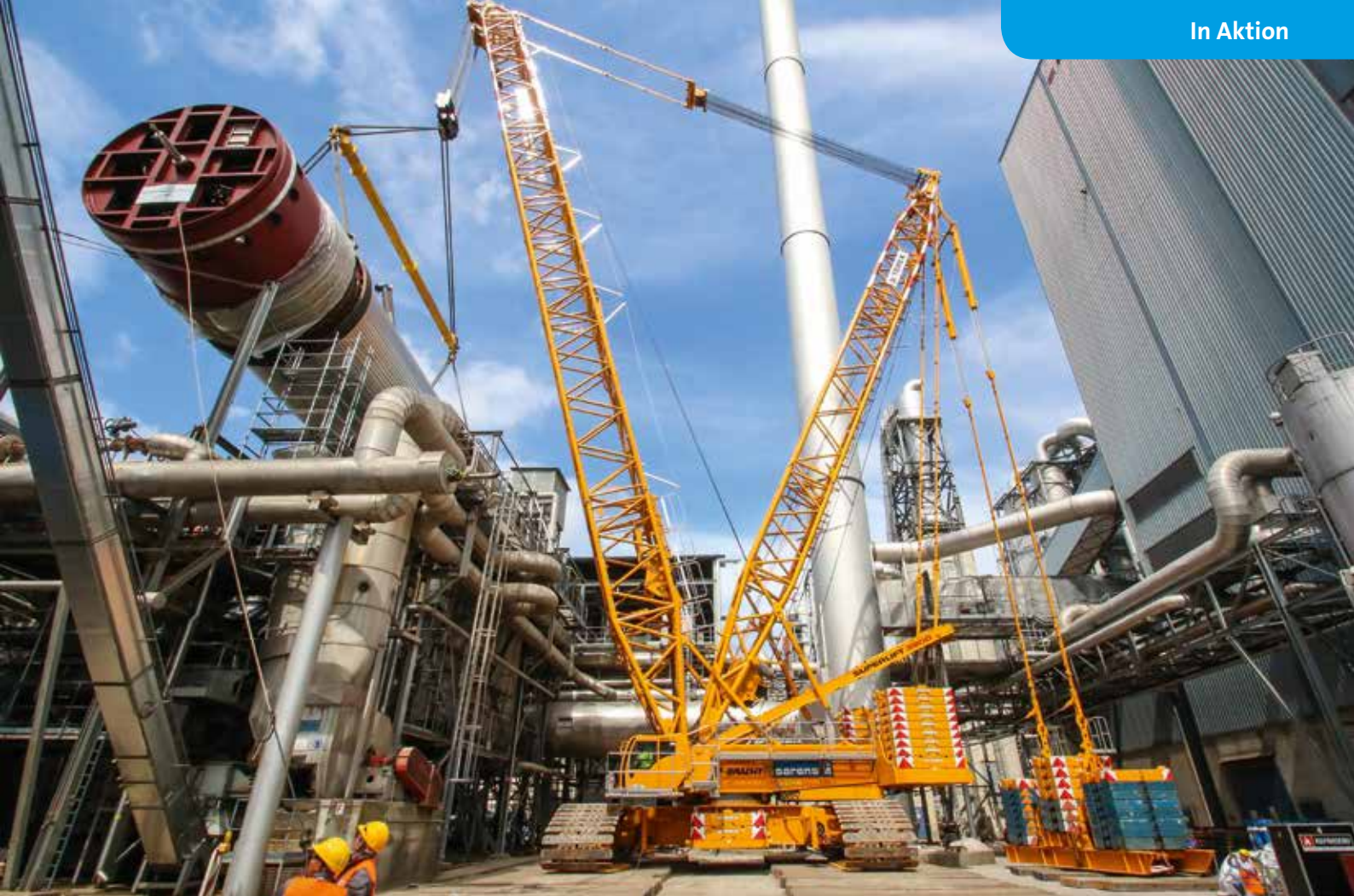
Nachdem die Last aufgenommen worden ist musste die Last um 90° geschwenkt werden.
