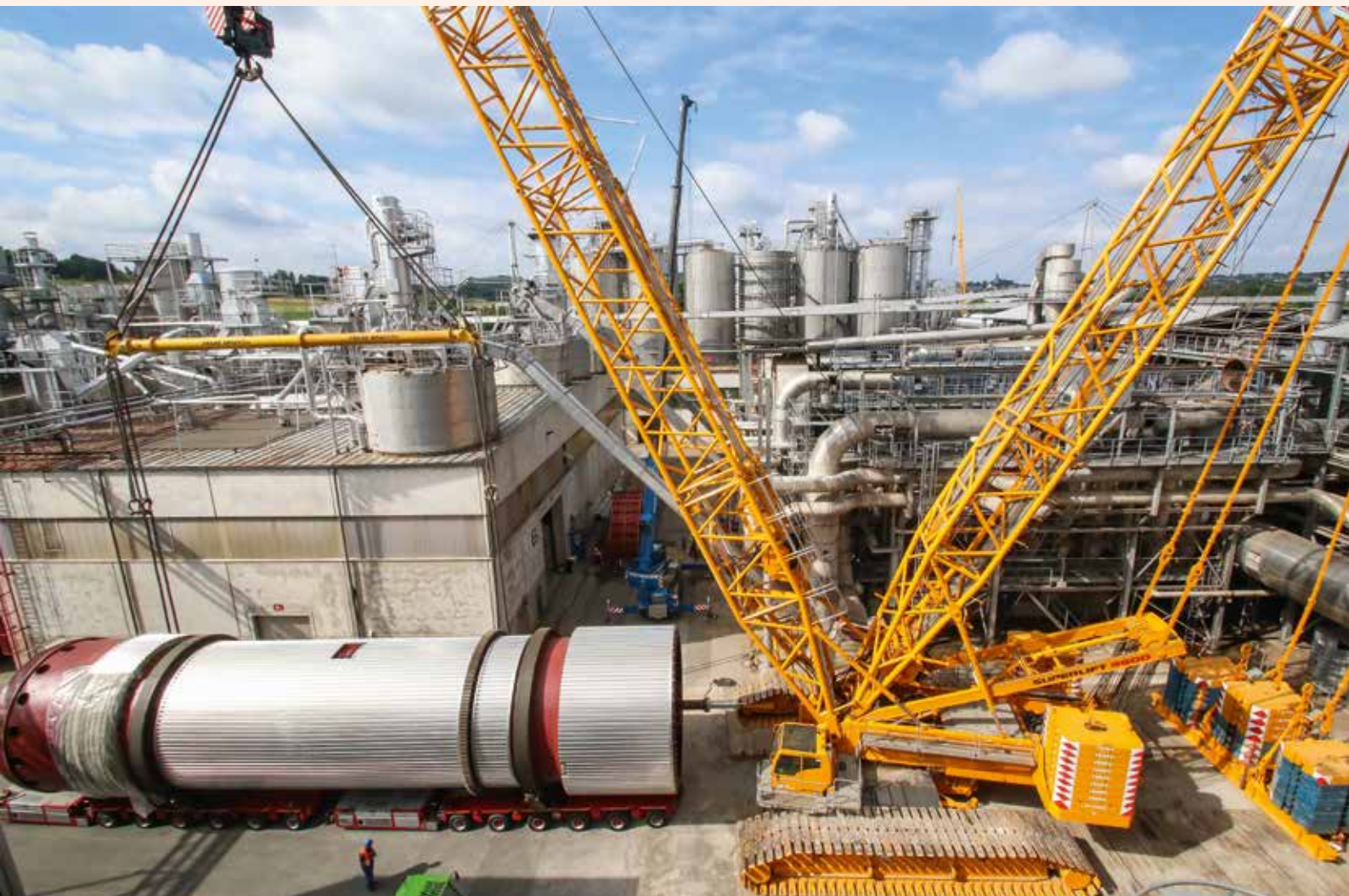
Eine spezielle Spreize ermöglichte diesen Solo-Einsatz.
