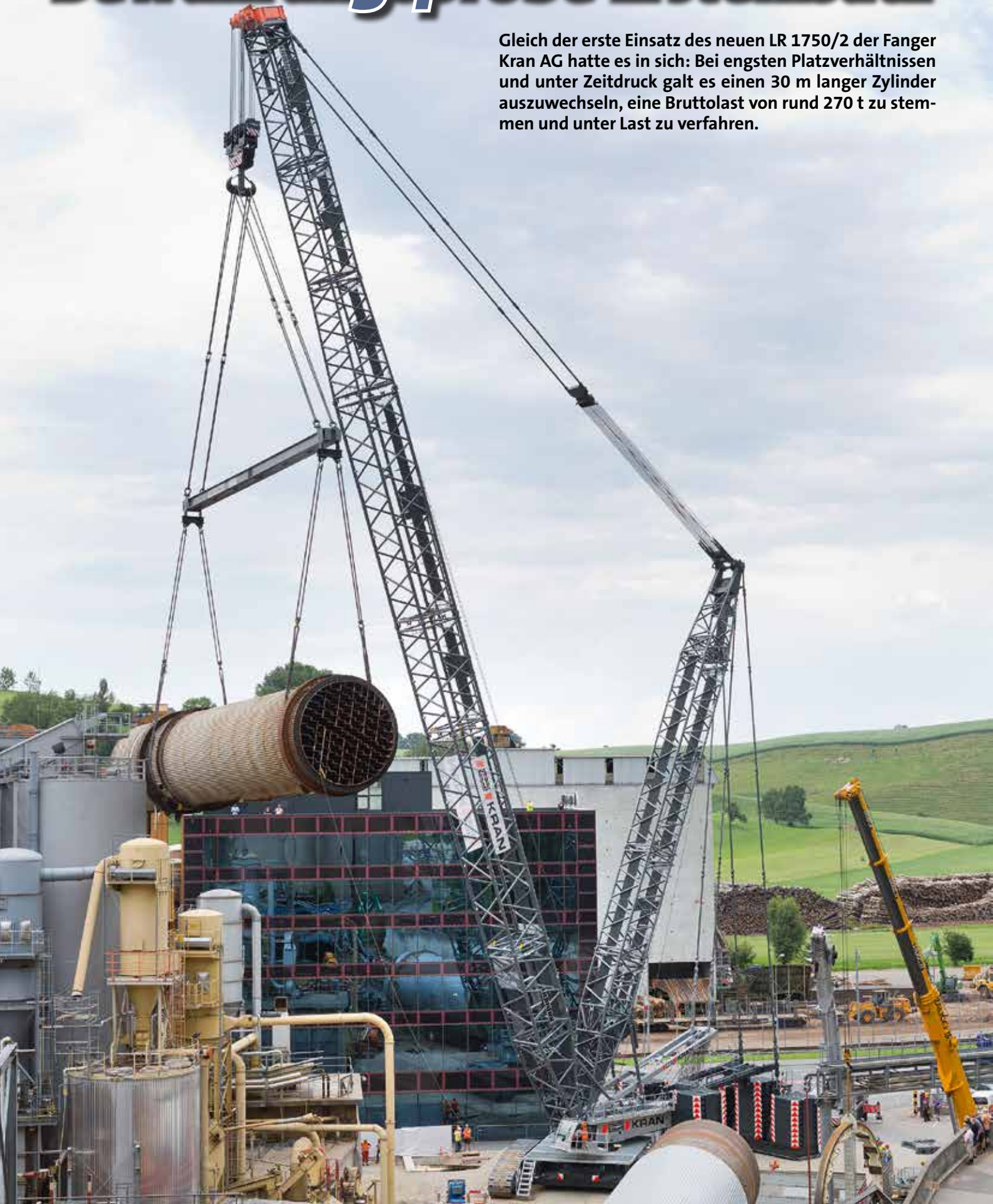
Der gigantische Stahlzylinder wird über die Produktionsanlagen gehoben.
