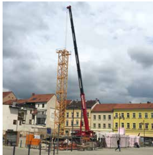
ATF 220G-5 von Henneberger bei der Errichtung eines Turmdrehkrans.
