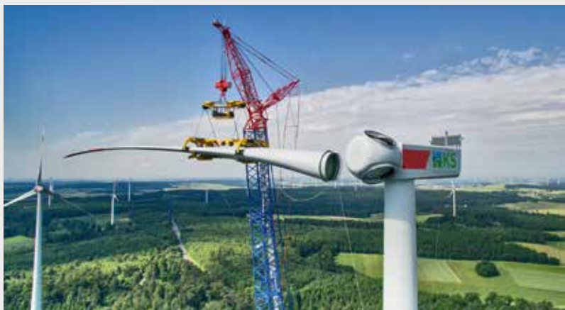
Der Allgäuer Spezialanbieter Ematec AG mit Sitz in Memmingerberg bei Memmingen hat nachgelegt und seine Rotorblatttraversen RBT und RBT Bunny für die Einzelblattmontage weiterentwickelt. Die Ematec-Traversen der neuen Generation weisen zum Beispiel den 180 Grad Blatt-Anschlag, Adaptierung an unterschiedliche Blattgrößen und eine erhöhte Traglast von bis zu 16 t auf. Außerdem neu sind ein Ferndiagnosesystem via Internet, ein Kettengehänge mit Ausgleichswippe, feuchtigkeitsabweisende Druckkissen, ein teleskopierbarer Anschlagpunkt für die persönliche Schutzausrüstung (PSA) sowie eine optimierte Beleuchtung. In Zukunft sollen die RBT und die RBT Bunny zudem über ein integriertes Kamerasystem und ein Steuerungs-Restart-System verfügen, der Neigewinkel der RBT Bunny für die optimierte Hasenohrmontage wird auf \pm 30 Grad ausgeweitet (bisher +30 Grad). Seine neuen Ideen stellte das Unternehmen auch auf der WindEnergy Hamburg vor.
