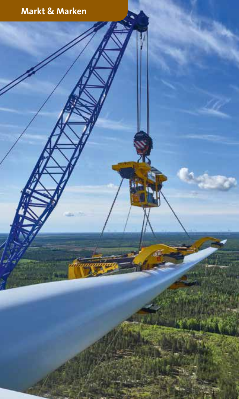
Der Allgäuer Spezialanbieter Ematec AG mit Sitz in Memmingerberg bei Memmingen hat nachgelegt und seine Rotorblatttraversen RBT und RBT Bunny für die Einzelblattmontage weiterentwickelt. Die Ematec-Traversen der neuen Generation weisen zum Beispiel den 180 Grad Blatt-Anschlag, Adaptierung an unterschiedliche Blattgrößen und eine erhöhte Traglast von bis zu 16 t auf. Außerdem neu sind ein Ferndiagnosesystem via Internet, ein Kettengehänge mit Ausgleichswippe, feuchtigkeitsabweisende Druckkissen, ein teleskopierbarer Anschlagpunkt für die persönliche Schutzausrüstung (PSA) sowie eine optimierte Beleuchtung. In Zukunft sollen die RBT und die RBT Bunny zudem über ein integriertes Kamerasystem und ein Steuerungs-Restart-System verfügen, der Neigewinkel der RBT Bunny für die optimierte Hasenohrmontage wird auf \pm 30 Grad ausgeweitet (bisher +30 Grad). Seine neuen Ideen stellte das Unternehmen auch auf der WindEnergy Hamburg vor.
