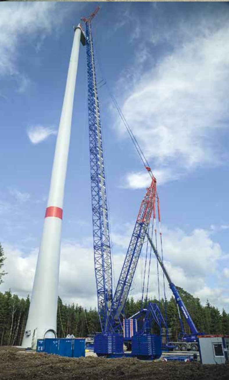
Beim Aufbau einer Nordex Windkraftanlage für den Auftraggeber „KS Regenerative Energie“ bei Bickenbach im Hunsrück setzte der Krandienstleister Hofmann Kran-Vermietung GmbH & Co. KG aus Paderborn auf den Gittermast-Raupenkran Demag CC 3800. Um die erforderliche Nabhöhe von 164 m zu erreichen, rüstete das Hofmann-Team den Kran mit vollem Boom Booster inklusive Flex Frame und Split Tray.
